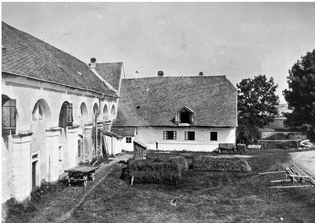
Pohled směrem na původní budovu ratejny A1
