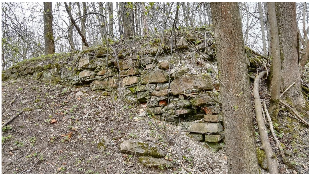
Zbytek nárožní zdi ratejny v jihovýchodní části bývalého dvora
