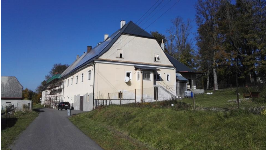
Budova kanceláří a bývalého vrchnostenského pivovaru od jihovýchodu-vstup do bytu na místě bývalého hvozdu pivovaru ( původně byly na tomto místě záchody, viz předešlé), dole malé okénko bývalé sladovny
