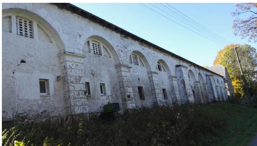
Hospodářská budova (A), za ním vpravo vykukuje budova dvora ( E ). Ve vrcholcích arkád jsou viditelné větrací průduchy seníku
