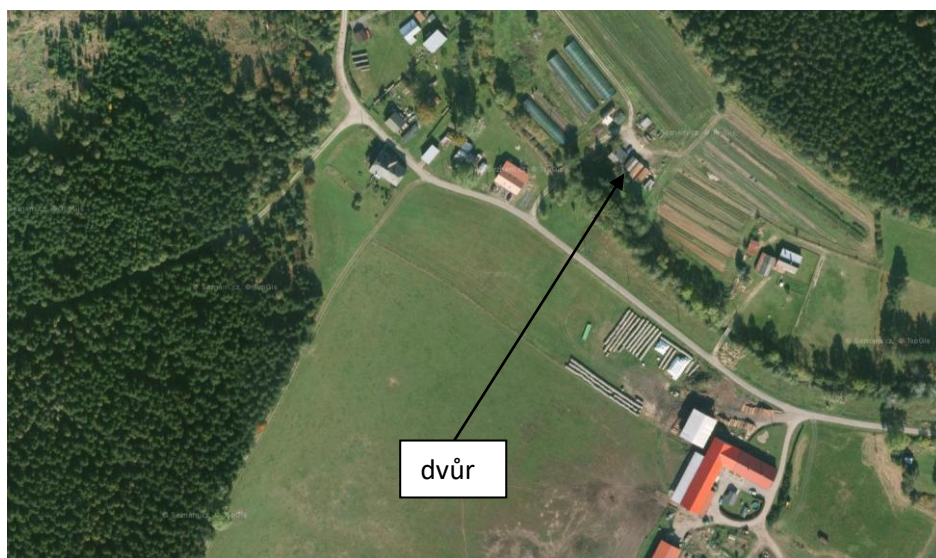
Současná nová zástavba na místě dvora
