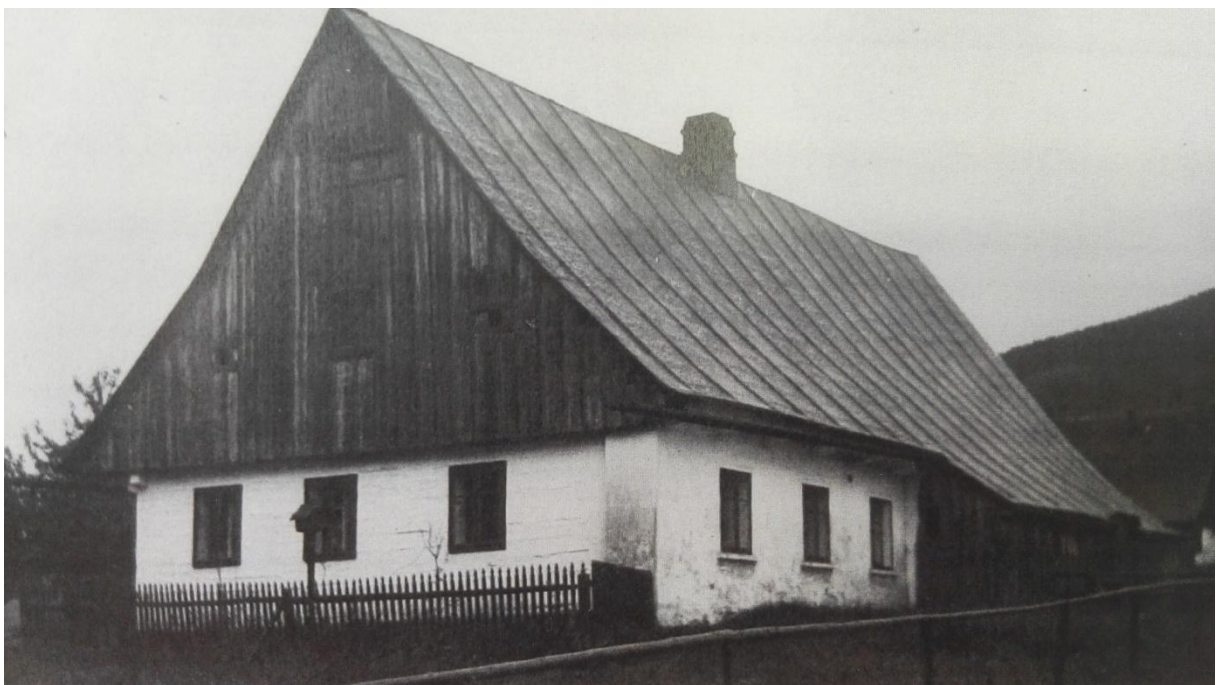
Myslivna v Boříkovicích č.p. 47 před demolicí
