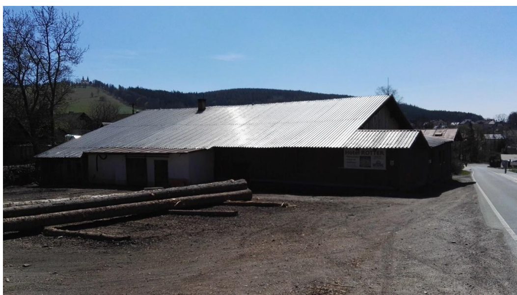
Pohled na bývalou vrchnostenskou pilu od severu
