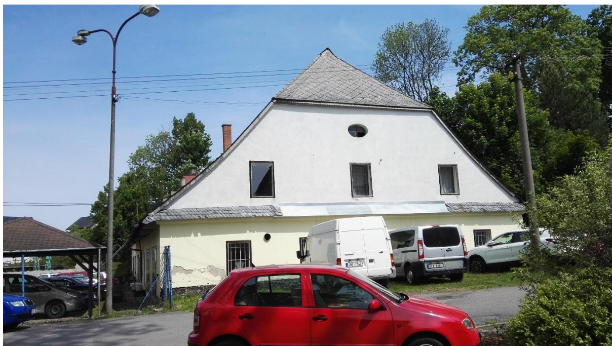
Bývalá vrchnostenská palírna-hlavní budova (1)
