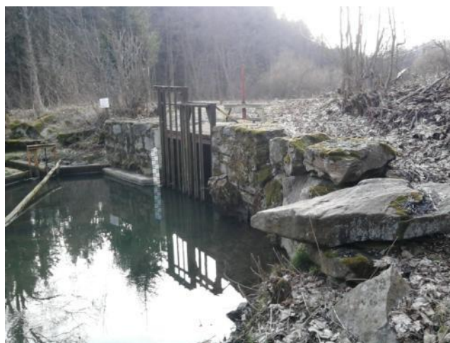
Vlevo detail vtokového stavidla, vpravo celkový pohled na vtokovou část podzemního potrubního přivaděče
