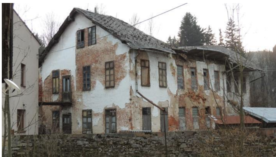
Pohled od severovýchodu
