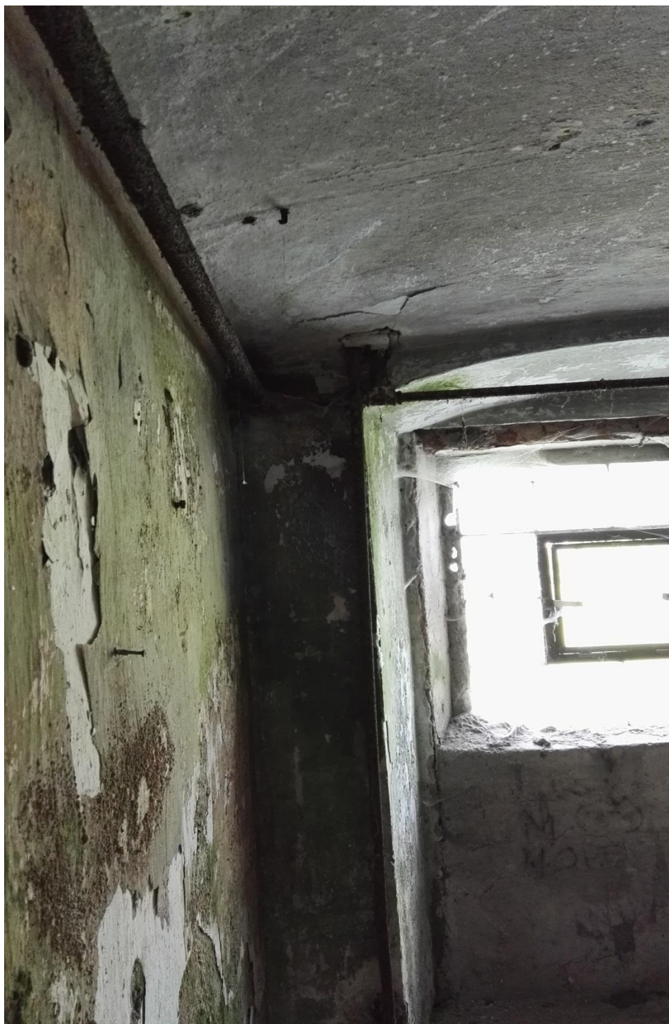
Dochovaný souvislý úsek potrubí soustavy parního ústředního topení v jedné z místností v přízemí, pod oknem byl původně radiátor
