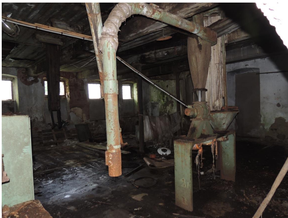
Výrobní hala ve spodním patře, vpravo opět zazděné dveře k vnitřnímu schodišti
