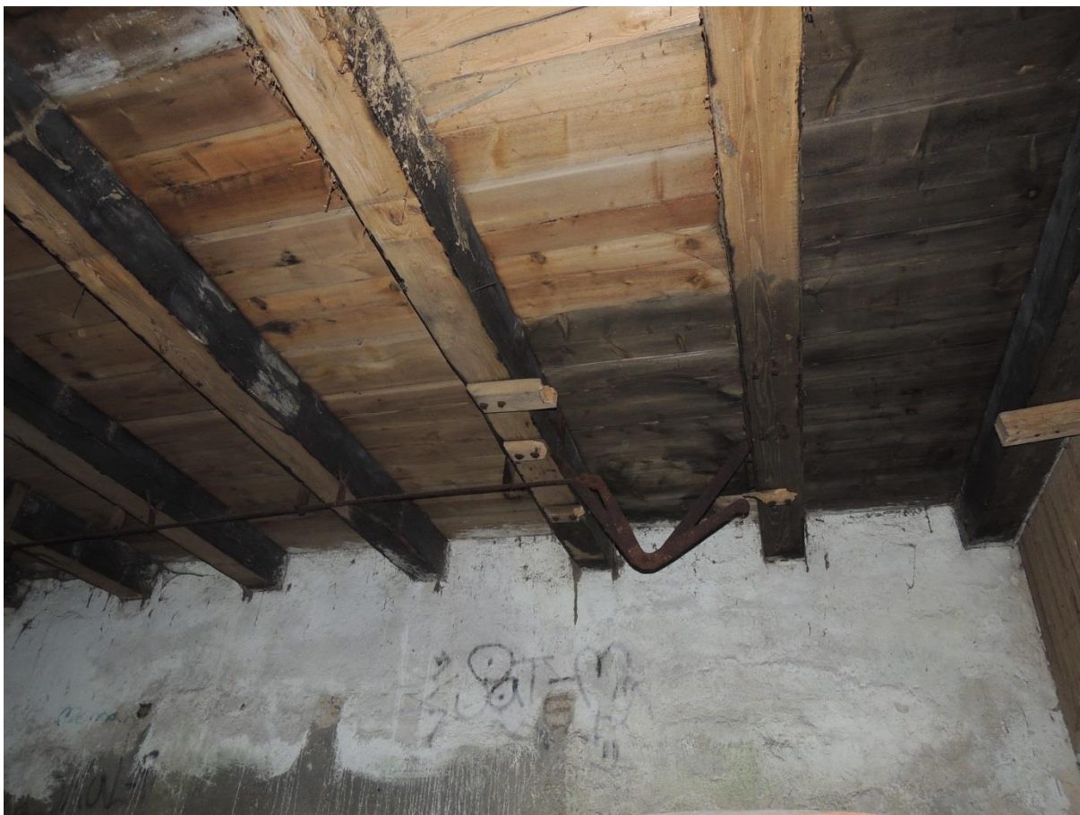
Zbytky ovladačů koncové regulace( hradidel) na stropě strojovny vodních kol
