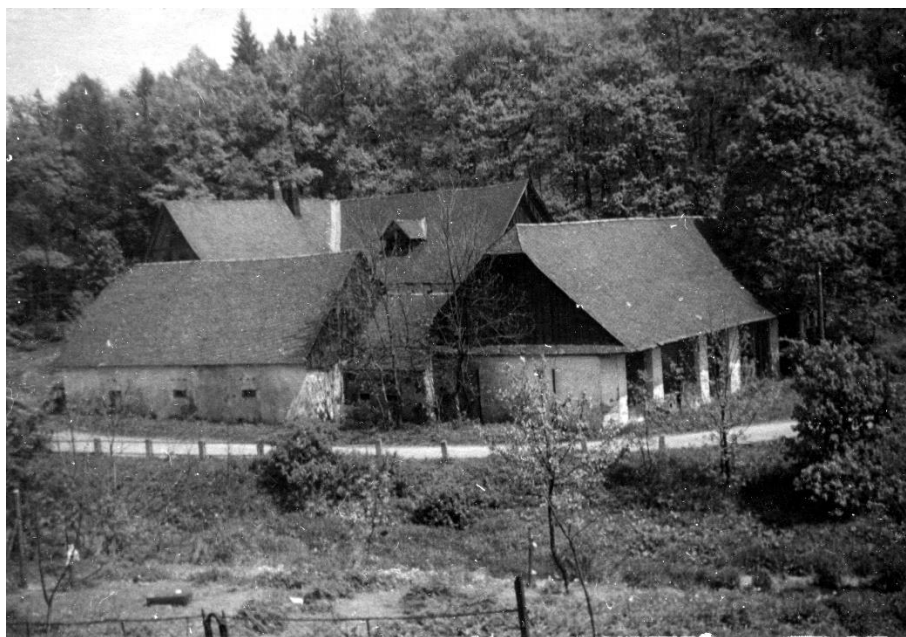
Pohled na areál spodního mlýna před demolicí
