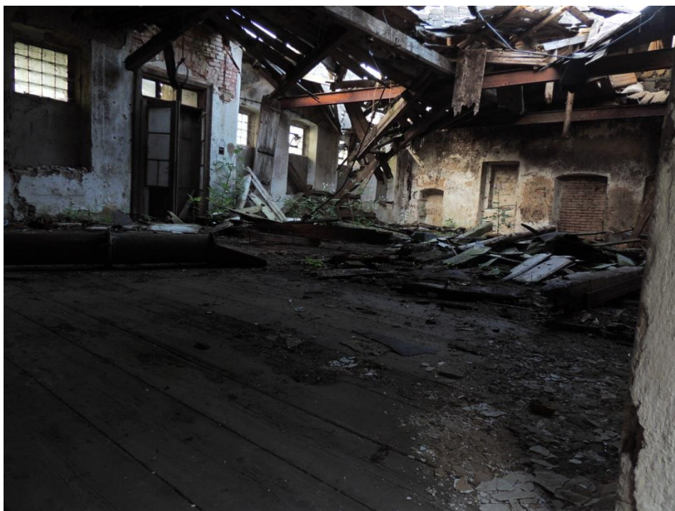
Výrobní hala v horním patře, v pozadí ve stěně mezi východním traktem a halou jsou zazděné dveře k vnitřnímu schodišti
