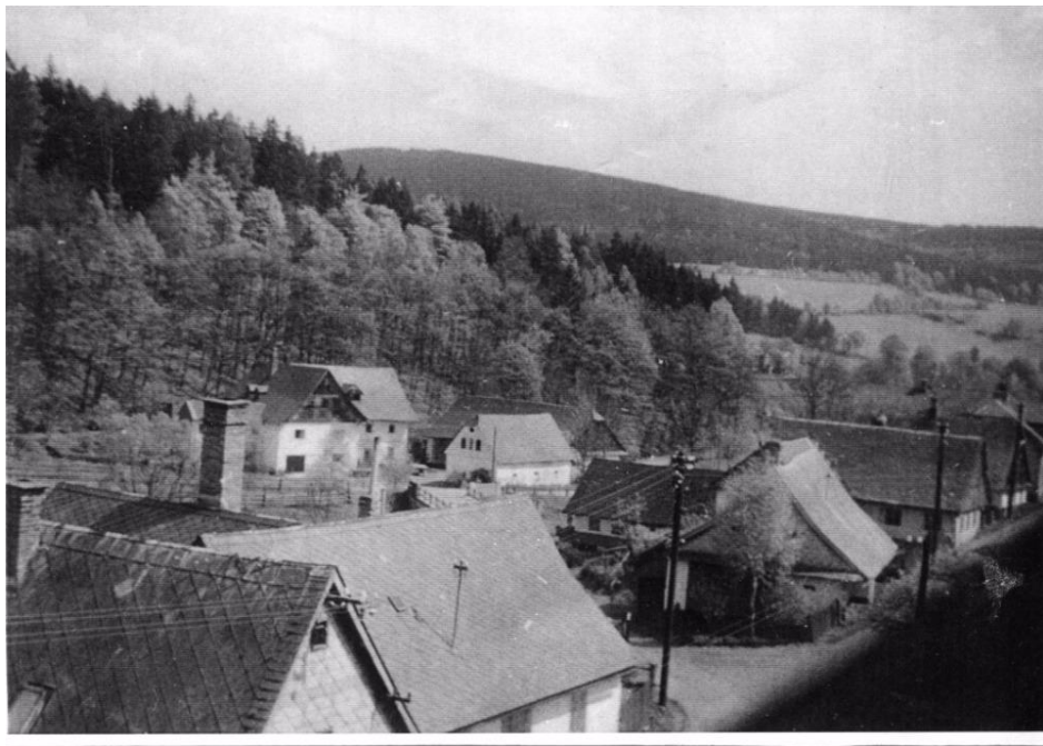
Pohled na areál spodního mlýna před demolicí
