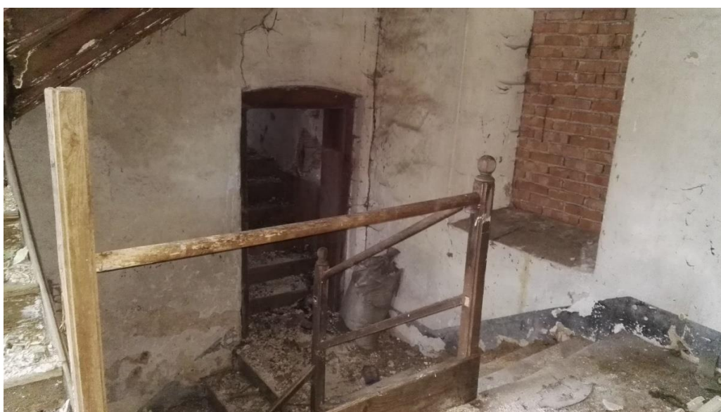
Vnitřní schodiště ve východním traktu, v pozadí vstup do spojovací chodby
