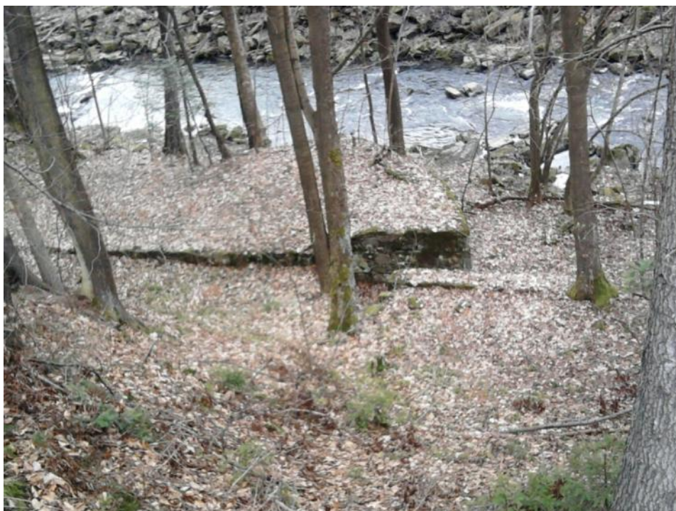
Celkový pohled na vtokovou část náhonu
