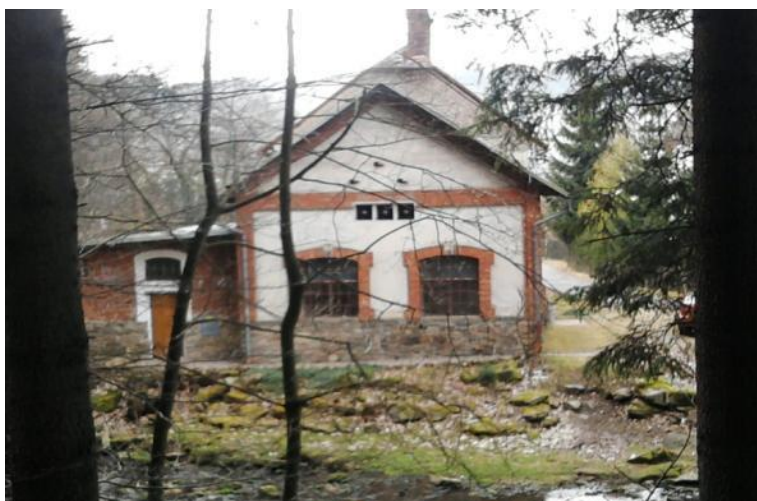
Pohled od východu, na průčelí je vidět třífázový vysokonapěťový výstup, pod ním v přízemí hlavní strojovna, vlevo v přízemí strojovna parního stroje/spalovacího motoru
