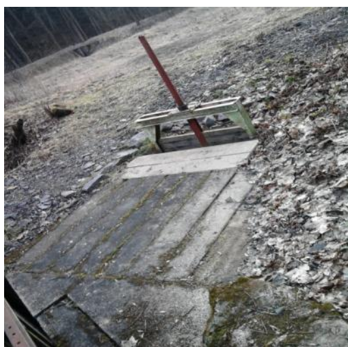
Vlevo detail vtokového stavidla, vpravo celkový pohled na vtokovou část podzemního potrubního přivaděče
