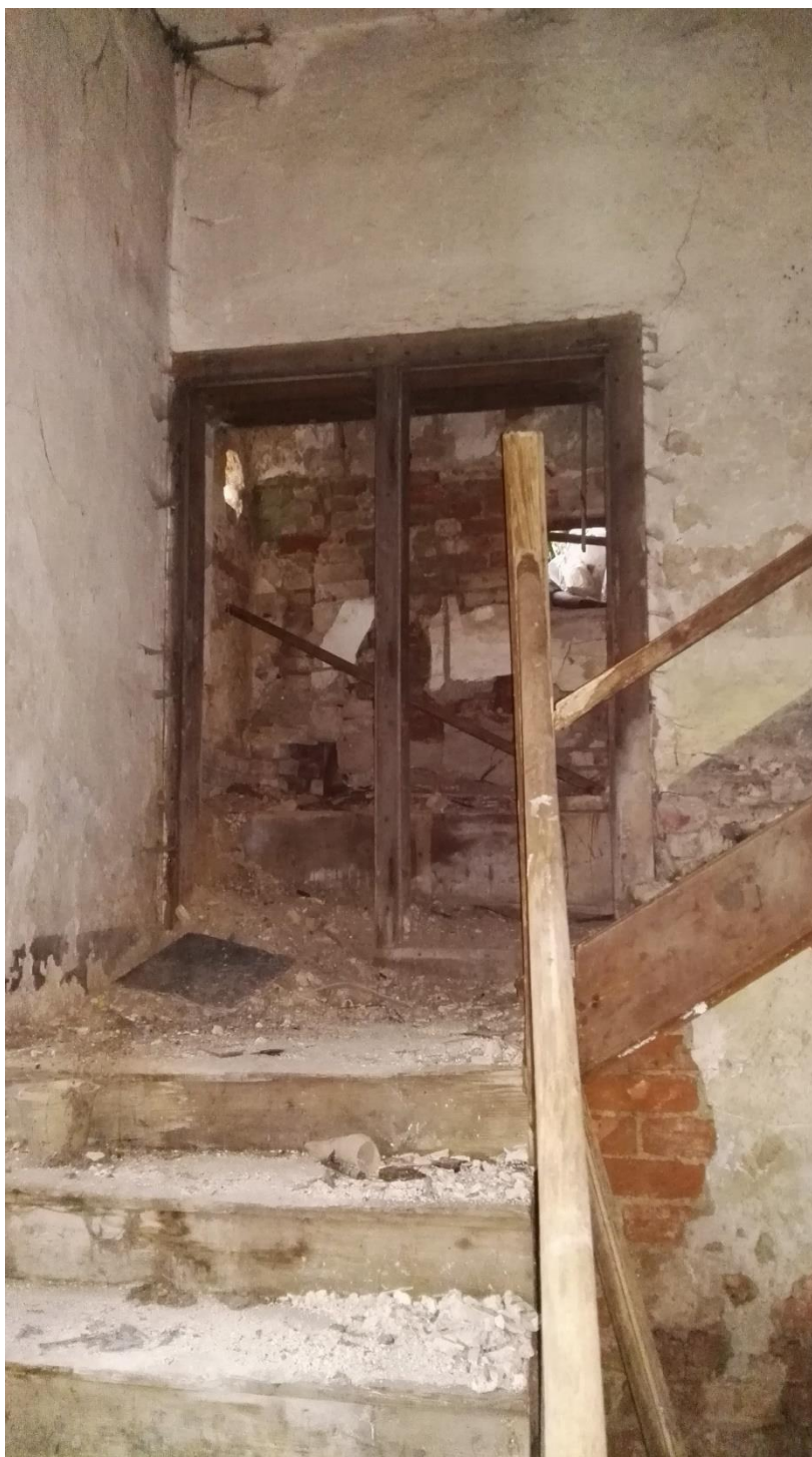
Pohled na spodní dvojici suchých záchodů v prostoru vnitřního schodiště východního traktu
