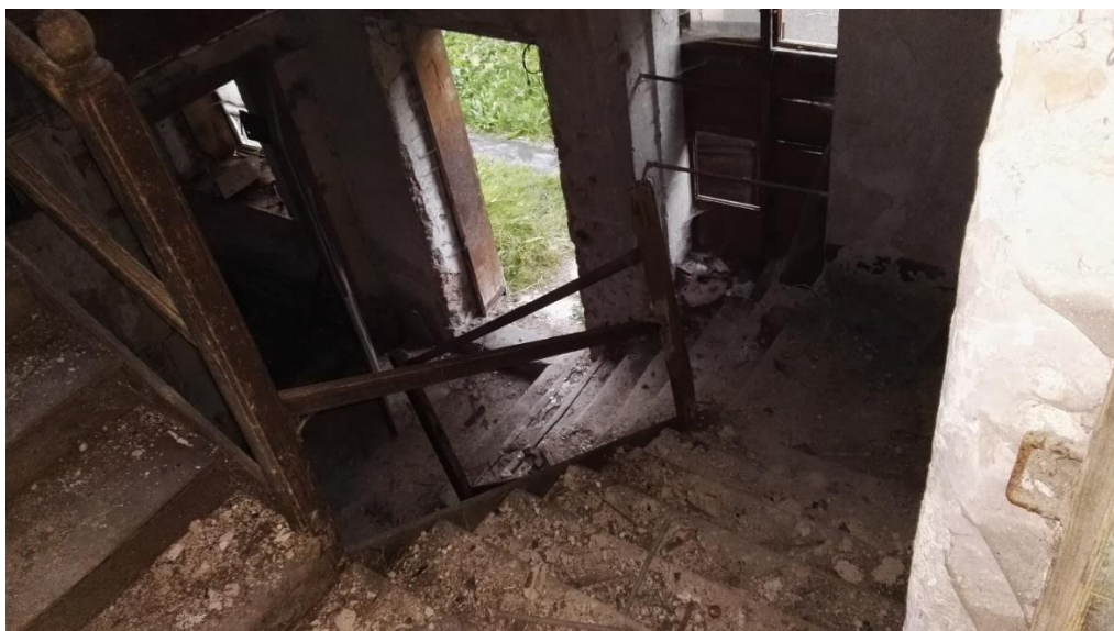
Pohled ze spojovací chodby k vnitřnímu schodišti ve východním traktu
