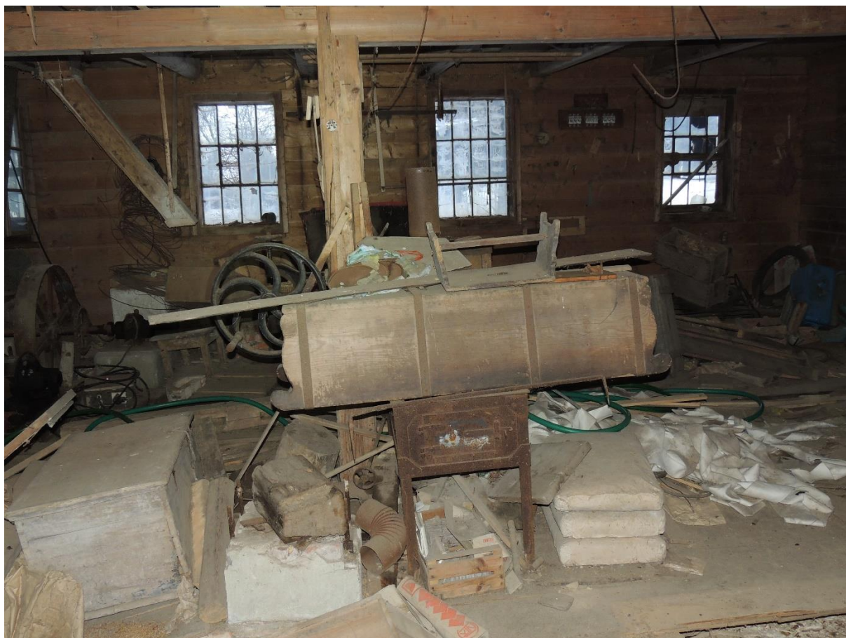
Velká místnost-pohled směrem k cestě.
