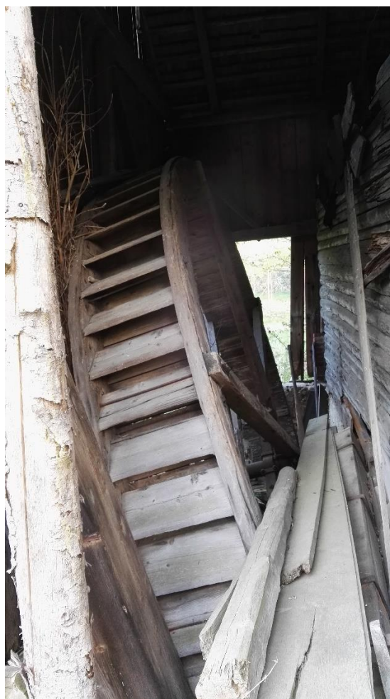
Pohled do prostoru vodního kola
