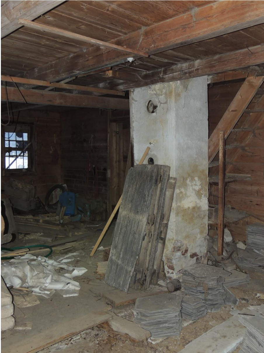
Velká místnost-pohled směrem ke vstupu . Vpravo vedle komína a schodiště původně stál ruční šroubový lis dnes umístěný v muzeu řemesel
