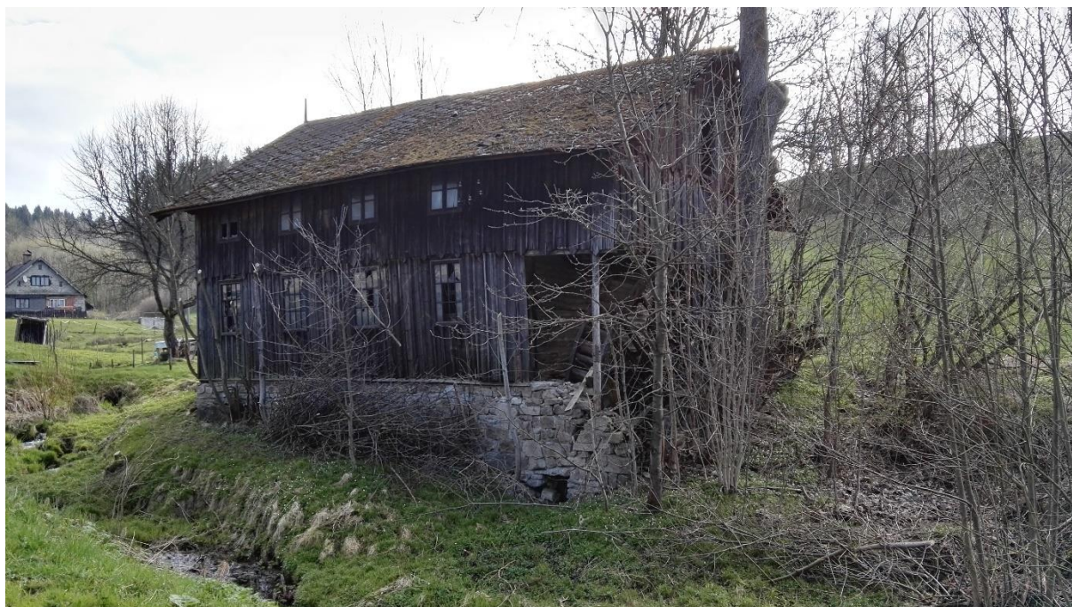
Pohled od jihozápadu k prostoru vodního kola-dole je viditelný otvor v podezdívce pro odtok vody od kola
